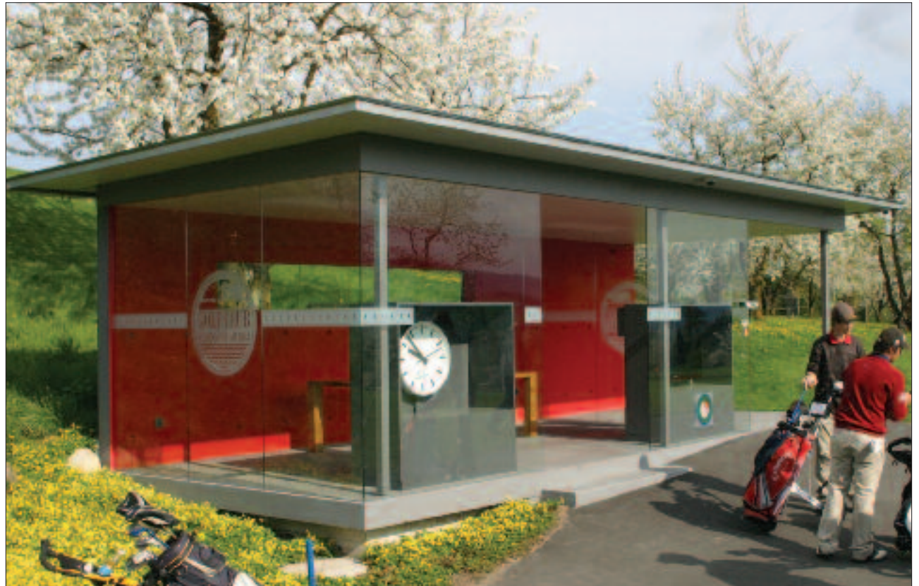
Das neue Starterhaus beim ersten Abschlag des 18-Loch-Parcours in der Küssnachter Grossarni bietet den Golferinnen und Golfern präzise Informationen und den Sponsoren eine gute Plattform.
